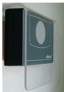
osłona zabezpiecza sterownik przed wpływem warunków atmosferycznych
